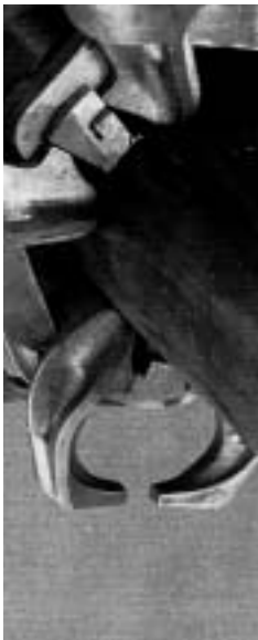
Konrad Wachsmann, nodo d'assemblaggio dell'hangar per l'aviazione militare americana, 1951
