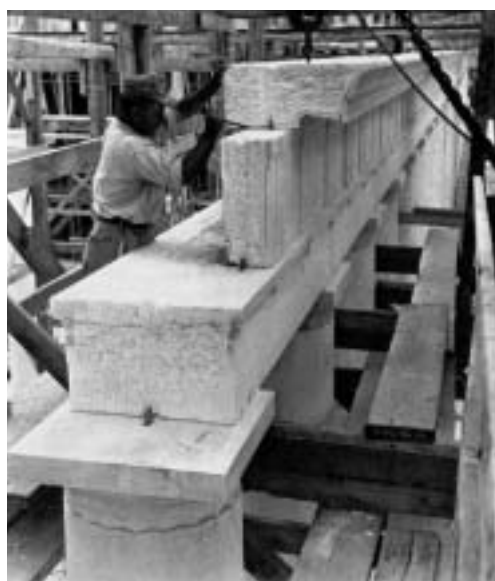
Atene, ricostruzione della Stoa di Attalo II a cura della Scuola archeologica Americana: messa in opera della trabeazione dell'ordine dorico del portico. La ricostruzione, con strumenti e tecniche originali, è degli anni 1953-56.
